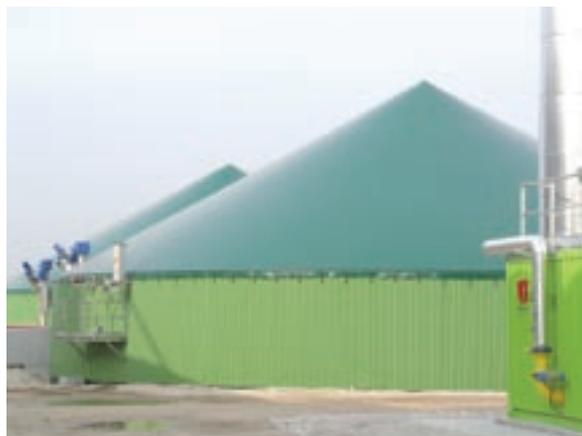
Tutte le vasche sono in c.a., cilindriche, alte 6 m, con una copertura flessibile a forma conica, costituita da un doppio telo, completamente coibentate e riscaldate, e al loro interno sono installati dei miscelatori elettrici sommersi. Anche grazie alla flessibilità d'uso della vasca dei residui, il tempo di residenza idraulica complessiva (HRT) è di ~100 d.
