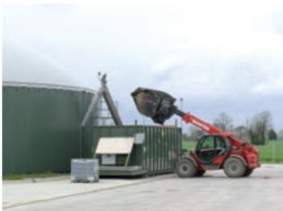
Tutte le vasche sono in c.a., cilindriche, alte 6 m, con una copertura flessibile a forma conica, costituita da un doppio telo. All'interno dei digestori e dei post-digestori, coibentati e riscaldati, sono installati dei miscelatori elettrici sommersi.
