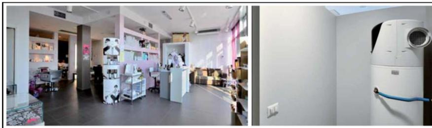
**Figura 5.** Installazione di uno scaldacqua a pompa di calore presso una parrucchiera; il calore è prelevato dal locale stesso.
