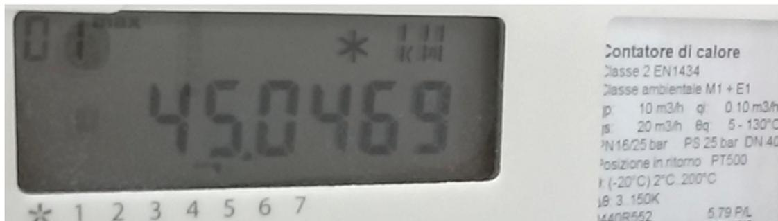
Dai contabilizzatori di calore è possibile rilevare i valori istantanei, medi e di picco dei consumi energetici, delle potenze erogate, delle temperature A/R impianto.
