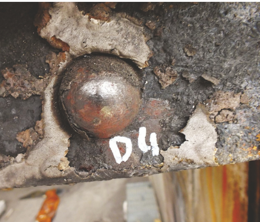
Fig. 10 - Un'utilizzazione relativamente "tipica" degli adattatori è per l'esecuzione di misure di durezza sulle teste di rivetti: nello specifico l'immagine si riferisce ad una serie di misurazioni eseguite su una struttura danneggiata dal fuoco per verificare o meno il danneggiamento da globalizzazione del materiale utilizzato proprio per i rivetti
