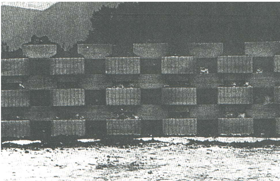
Figura c. Barriera a muro cellulare e elementi vegetali.
