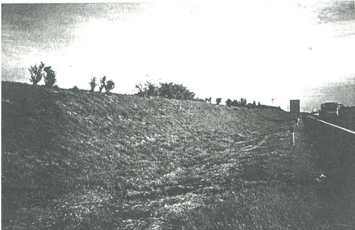
Figura b. Barriera in terra armata e inerbita.
