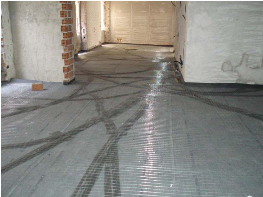
Figura 4. Isolamento acustico dei solai in legno/ferro.
