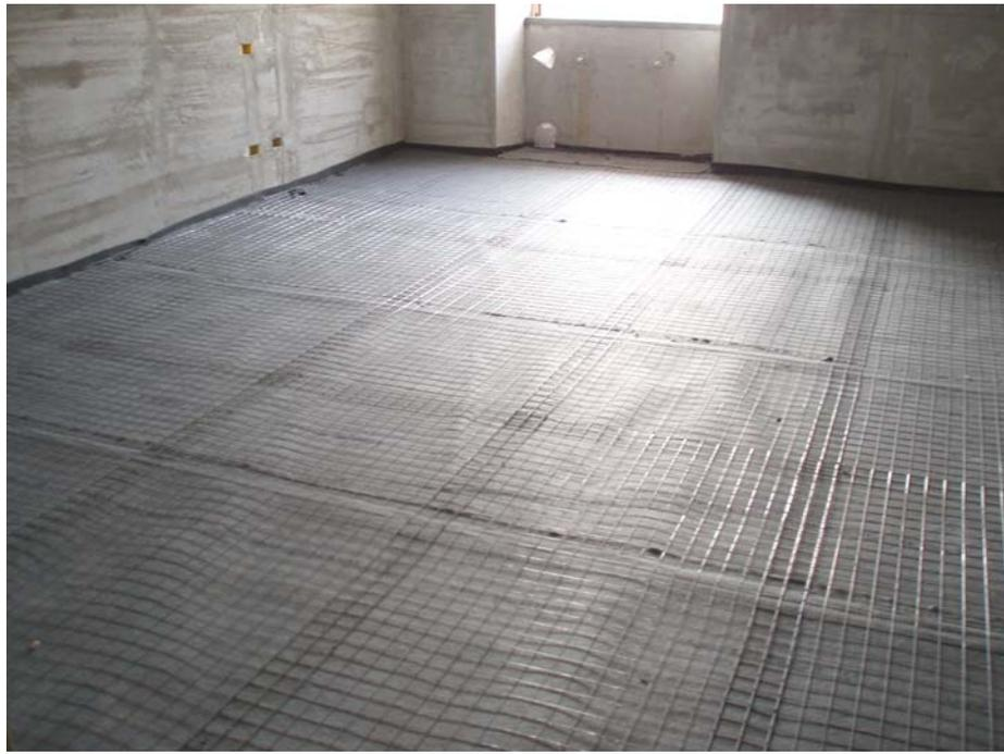
Figura 5. Isolamento acustico dei solai in legno/ferro
