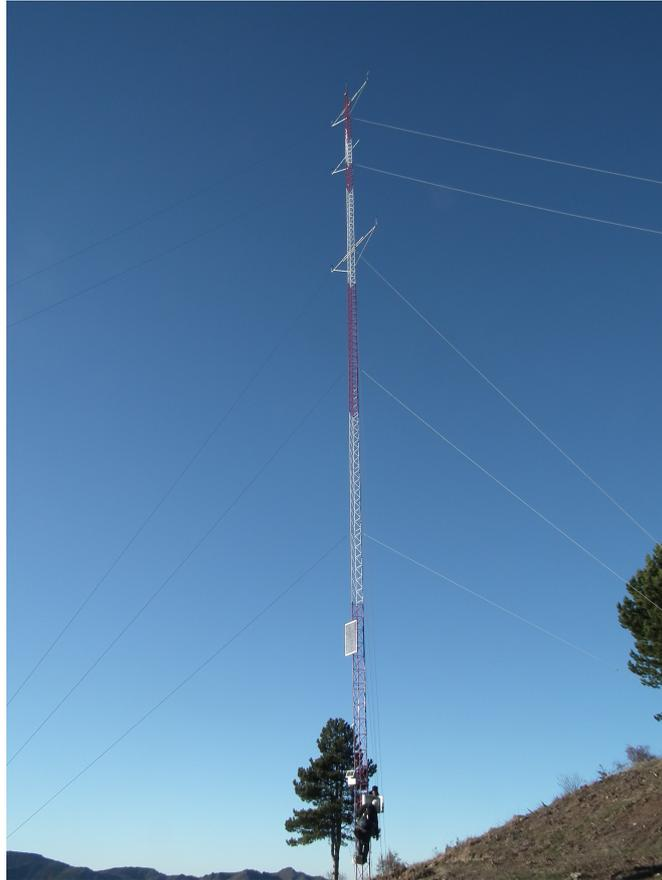
*Figura 4.2 – Torre a traliccio con tiranti per stazione di misura*
