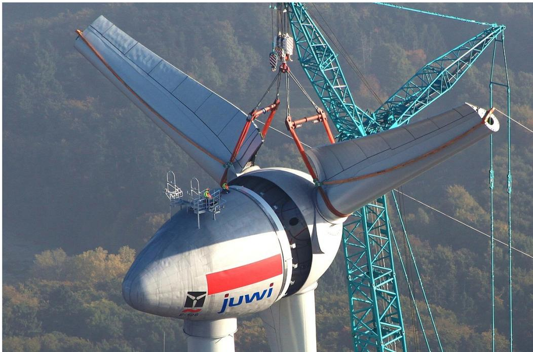
*Figura 4.13 – Montaggio del rotore di un aerogeneratore*
