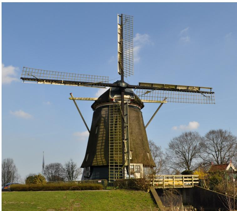
*Figura 2.2 – Mulino olandese dotato di "cappello"*
