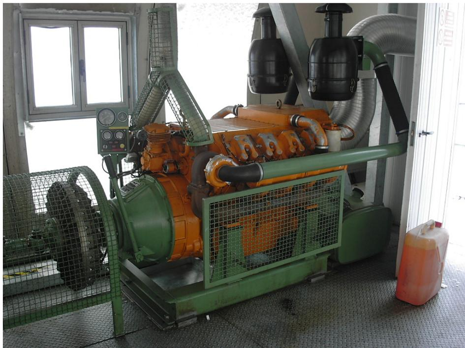
Figura 14 – Giunto idraulico
