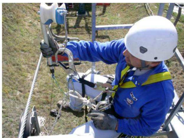
Figura 2 – Accesso al sostegno del soccorritore aereo (in alto) e predisposizione del carrello sulla fune (in basso)
