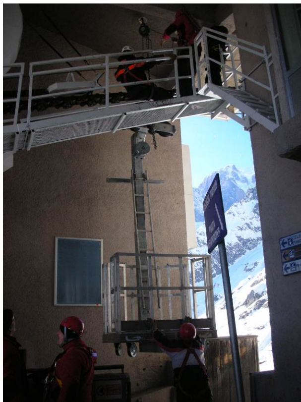
Figura 12 – Operazioni di predisposizione del carrello in stazione
