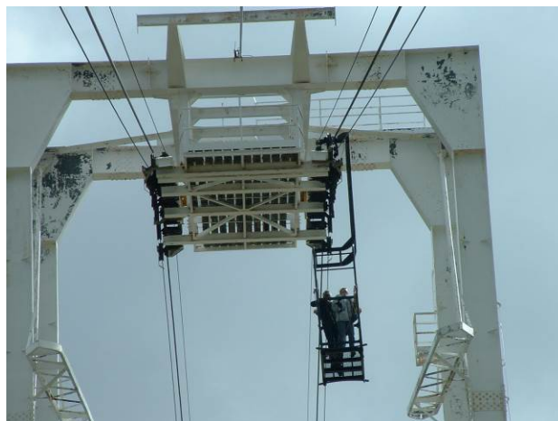
Figura 13 – Passaggio del sostegno con il carrello di soccorso
